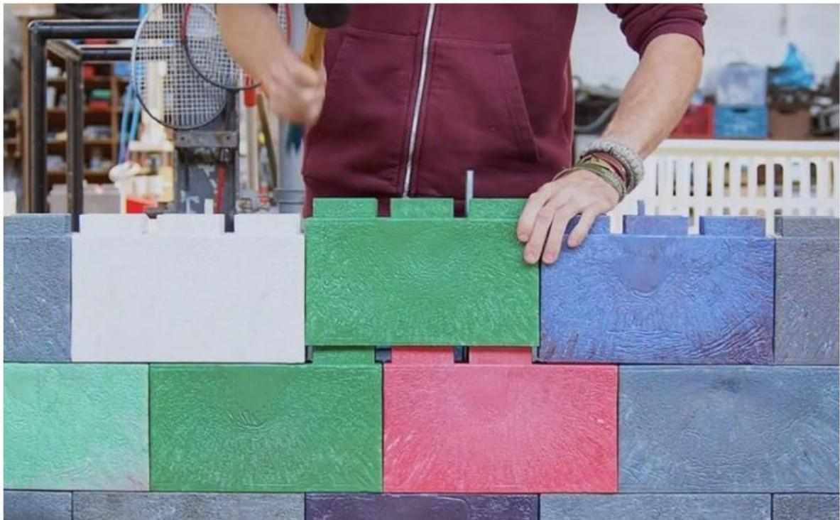
**Figure 4.2 :** Briques en plastique recyclé (Construiesamaison.com).
